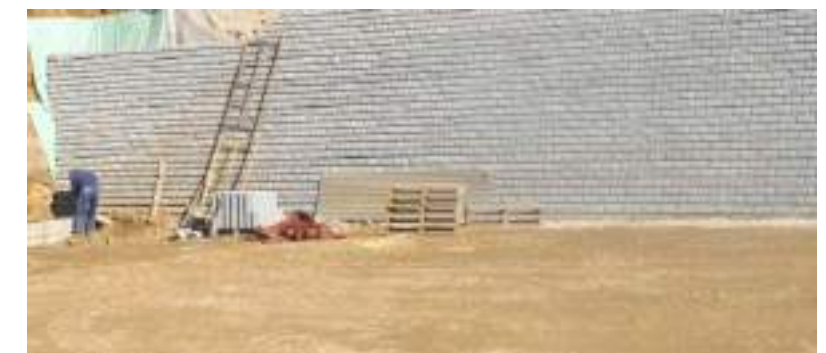
Obras no relvado sintético de Cernache do Bonjardim
