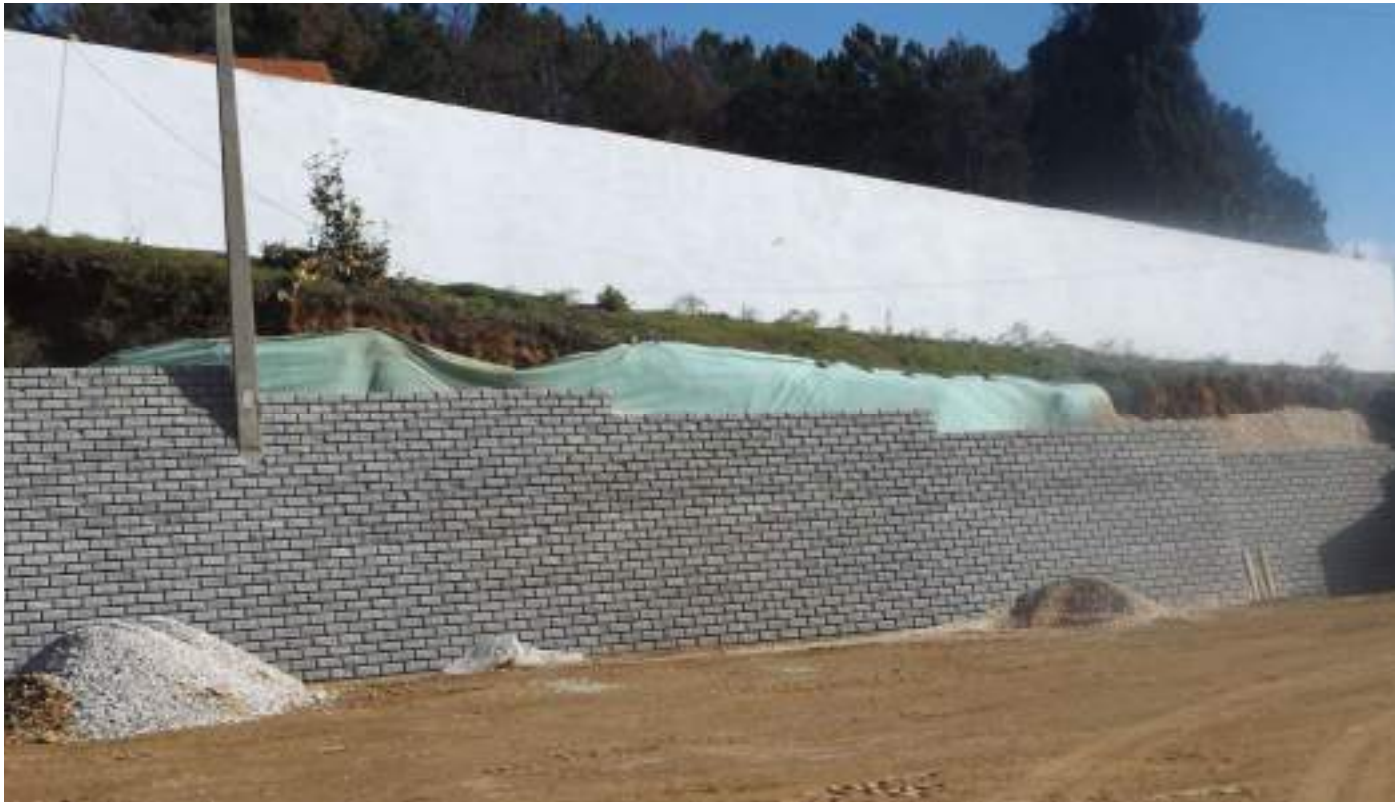
Obras no relvado sintético de Cernache do Bonjardim
